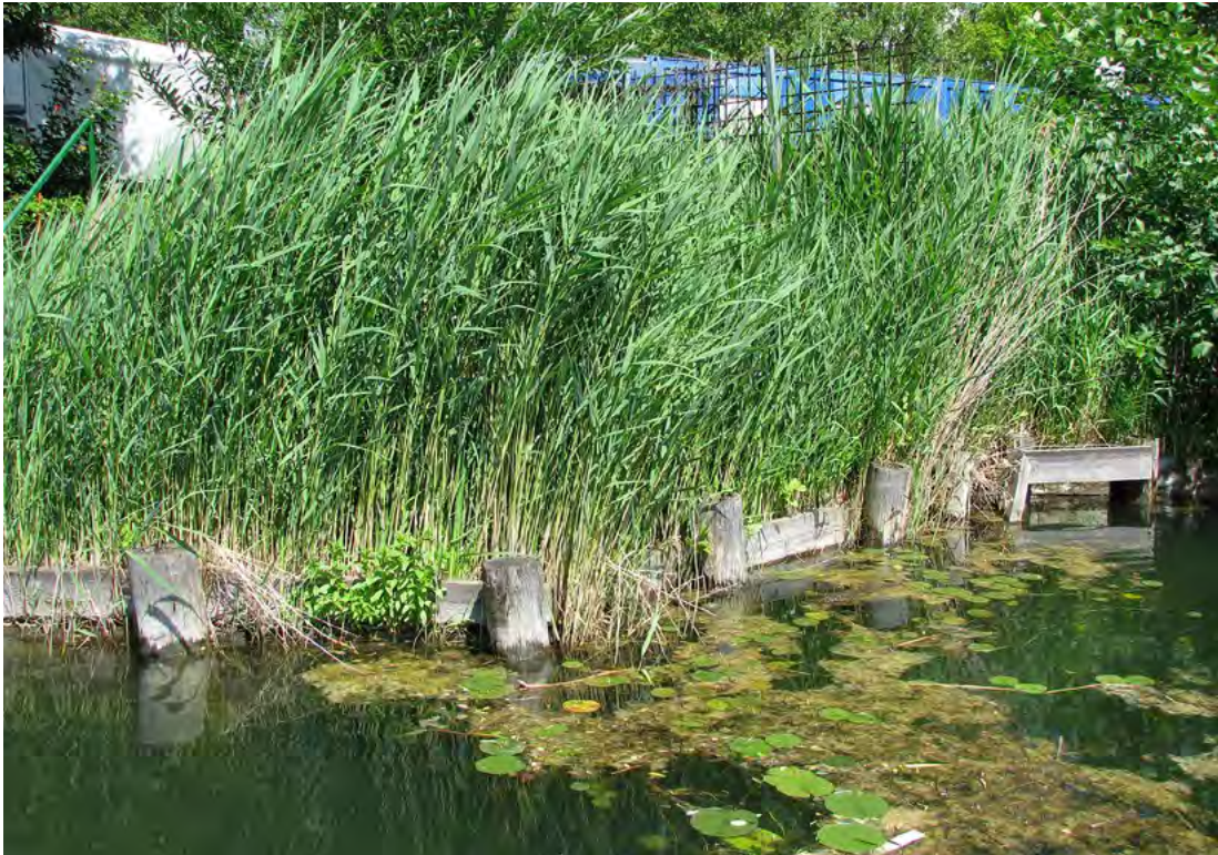
Probestelle 49: Diese Uferstrukturen im Kaiserwasser sind nur bei höheren Wasserständen funktionsfähig.
