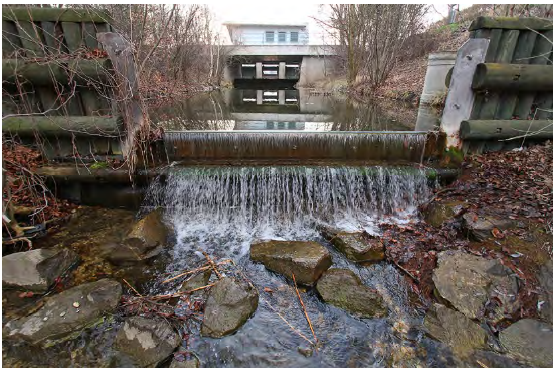
Das obere Ende der Versuchsstrecke: Das Messwehr mit dem Schützenhaus im Hintergrund.
